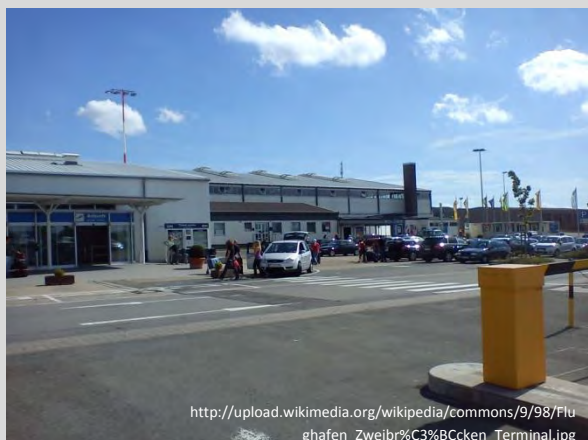
Terminal des Flughafens Zweibrücken
