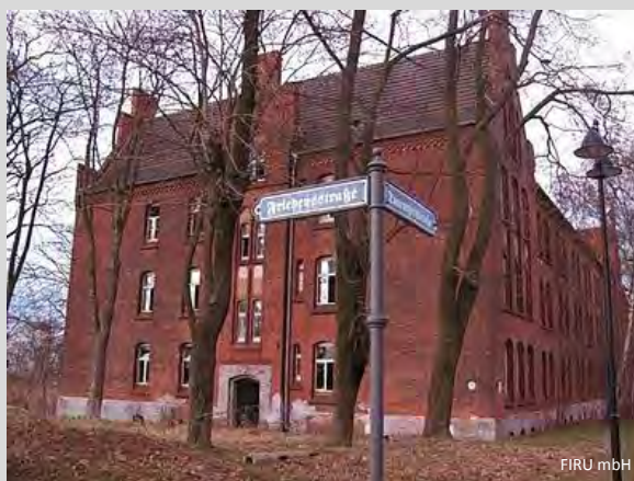
Teils sanierte und bewohnte Altbauten
