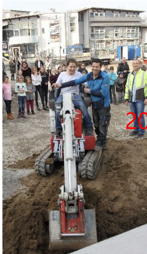
Beginn der Bauarbeiten
