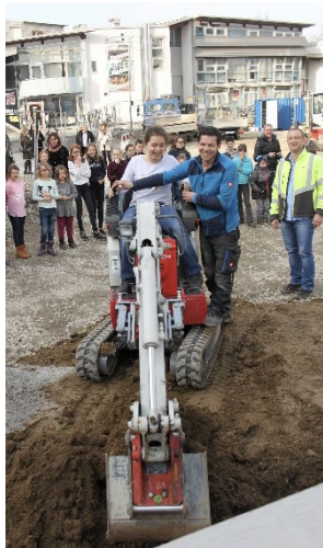
Beginn der Bauarbeiten
